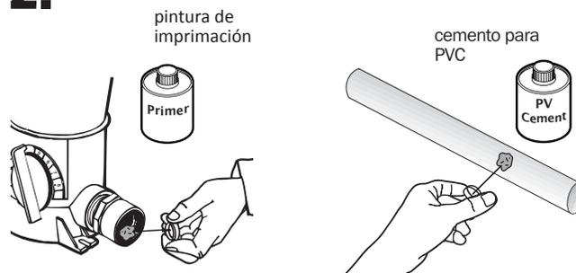
Siguiendo las instrucciones de la pintura de imprimación, aplíquela en el interior de los adaptadores y en los extremos de la tubería. Repita este proceso con cemento para PVC siguiendo las instrucciones del producto.
